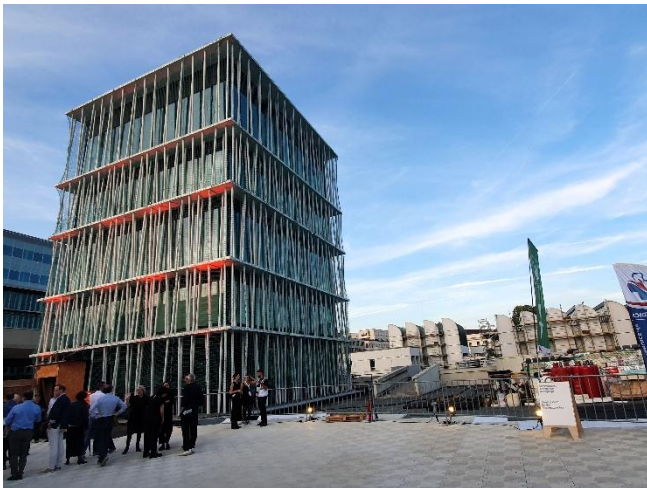
Baustelle des Bauhaus-Archivs mit dem fast fertigen Turmbau im Vordergrund und im Hintergrund rechts dem Bestandsbau mit den charakteristischen "Shed-Dächern" von WALTER GROPIUS Foto: Frank Jahnke
