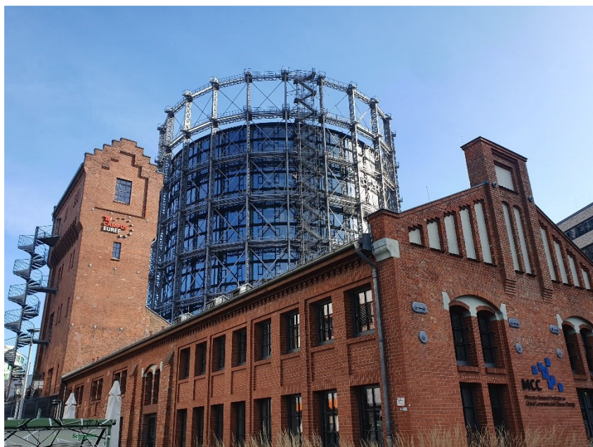
Auf dem EUREF-Campus gehen Traditionspflege und Fortschritt Hand in Hand: Der vorbildlich restaurierte ehemalige Wasserturm vor dem ausgebauten Gasometer.
