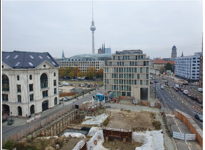
Blick vom PETRI Berlin auf den Petriplatz in Richtung Osten: In der Bildmitte die Baustelle für das »House of One« und das dahinter liegende Hotel am Ort des einstigen Cöllner Rathauses, rechts die Gertraudenstraße, links ein Teil des früheren Warenhauses Hertzog Foto: Frank Jahnke
