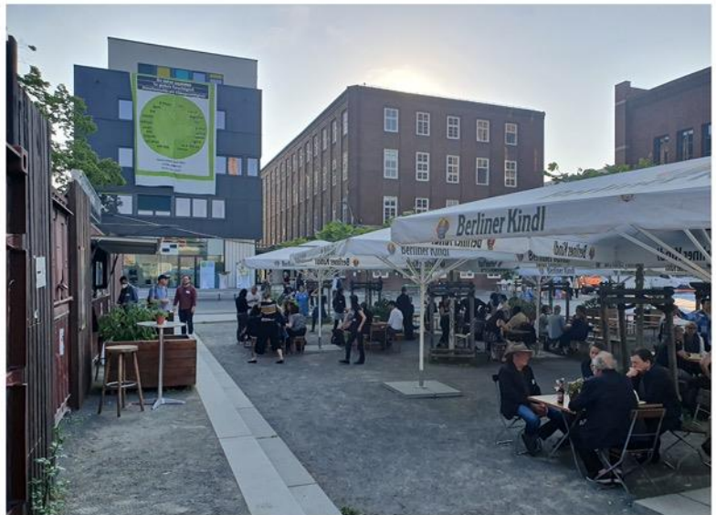
»Berliner Kindl« liefert zwar noch das Bier zum Fest, aber auf dem Gelände steht nun das Eine-Welt-Zentrum: Rechts das ehemalige Kindl-Verwaltungsgebäude, links in blau und grün der gerade fertiggestellte Neubau Foto: Frank Jahnke
