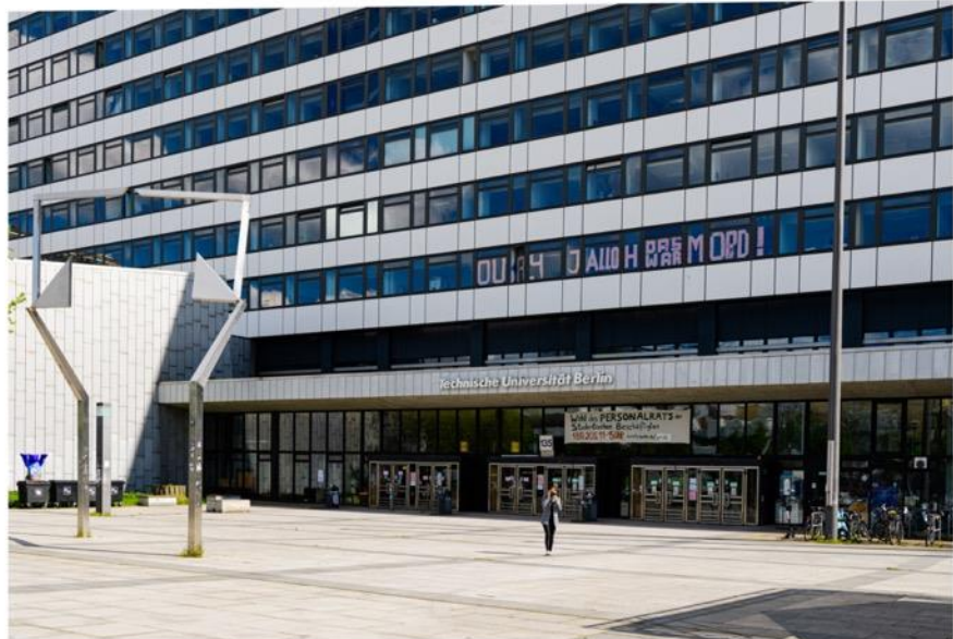
Das neue Hauptgebäude der TU aus den 1960er Jahren Foto: Antonia Schneider
