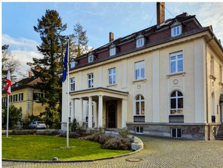
Sitz der EAB in einer ehemaligen Fabrikanten-Villa in Berlin-Grunewald Foto: Frank Jahnke
