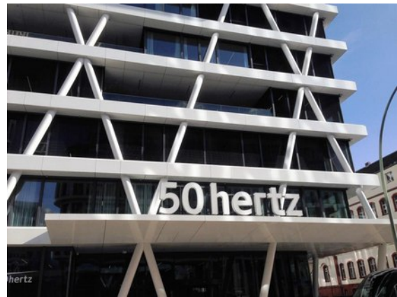
Die von Grazer Architekten entworfene Unternehmenszentrale der »50 Hertz Transmission GmbH«, ein Blickfang in der Heidestraße unweit des Hauptbahnhofs.
