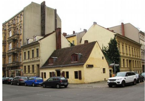
An der Wilmersdorfer Straße/Ecke Haubachstraße kann man die verschiedenen Bauphasen deutlich wiedererkennen. Foto: Dierk Spreen
